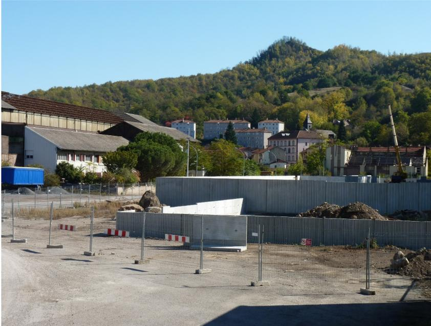
Mur de confinement réalisé en béton préfabriqué pour accueillir les terres excavées des terrassements.
